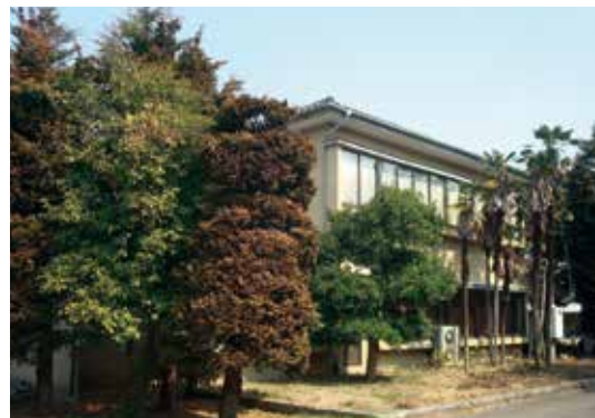
旧平岡レース事務所棟
